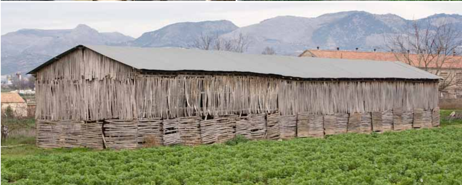
4. Secadero de tabaco de ladrillo y madera de 1953 en Belicena (Vegas del Genil), actualmente es un Centro de Interpretación de la Vega de Granada 5. Secadero de tabaco de ladrillo y madera en Santa Fe al inicio de la carretera a Chimeneas 6. Secadero de palos en Santa Fe Fotos: Juan Carlos Cazalla, IAPH
