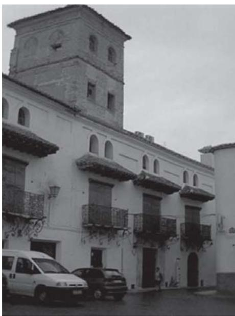
Los materiales empleados en su construcción son fundamentalmente el sillar pétreo o el ladrillo para los muros, la madera para la carpintería exterior, y la forja para los cerramientos de ventanas.
