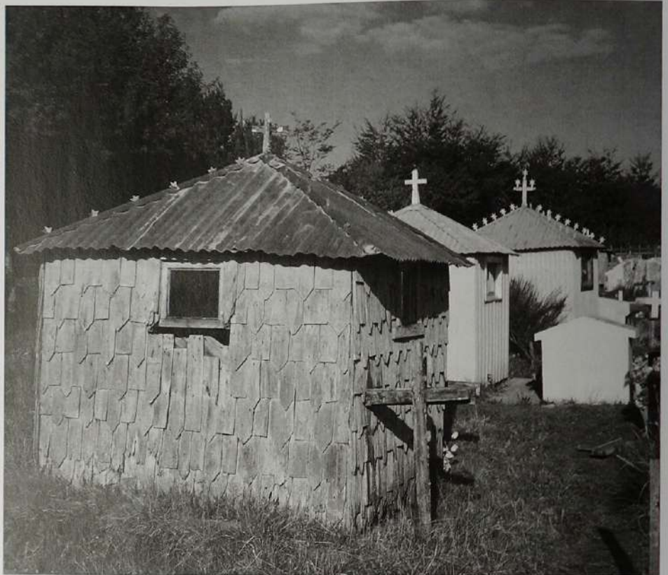
Panteones construidos con los materiales típicos de la arquitectura de Chiloé. Cementerio de Teupa, Chiloé (Chile), octubre 2013
