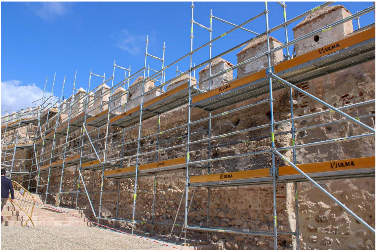
Fig. 3. Vista de las obras de rehabilitación de la muralla norte de la Alcazaba de Almería. Fotografía de la autora.
