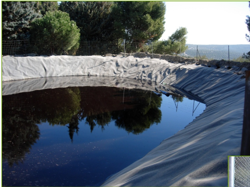
Balsa de aguas de lavado de aceitunas
