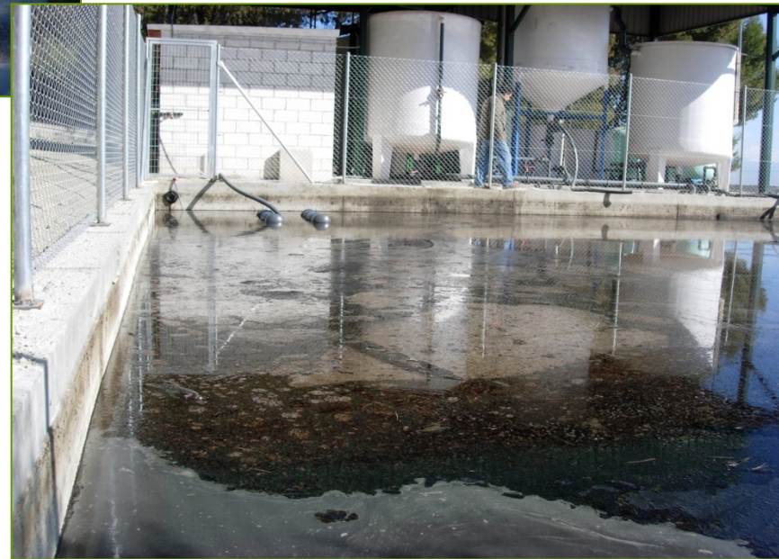
Balsa de aguas de lavado de aceite.
